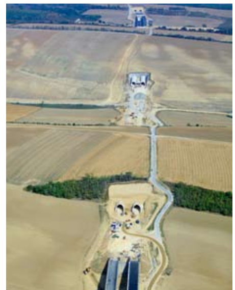
Insgesamt vier doppelröhrige Tunnel mit einer Gesamtlänge von 3,1 km entstehen beim Autobahnprojekt M6/M60
